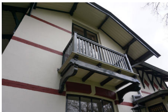
Balkon aan westgevel
