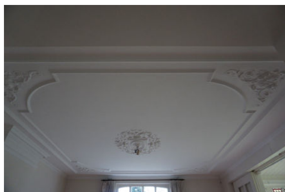
Stucplafond in zuidelijke woonkamer
