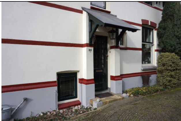
Entree in oostgevel
