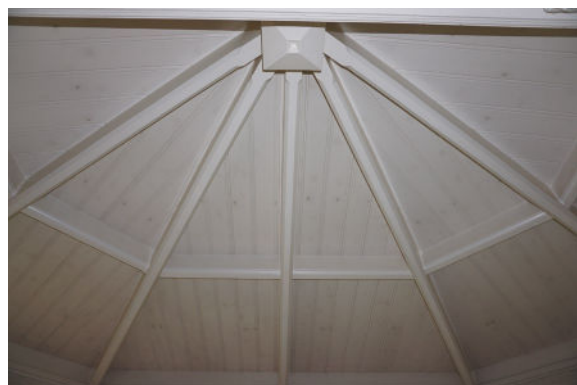
Houten dak van serre
