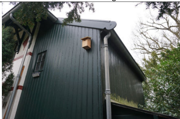
Houten aanbouw tegen noordgevel
