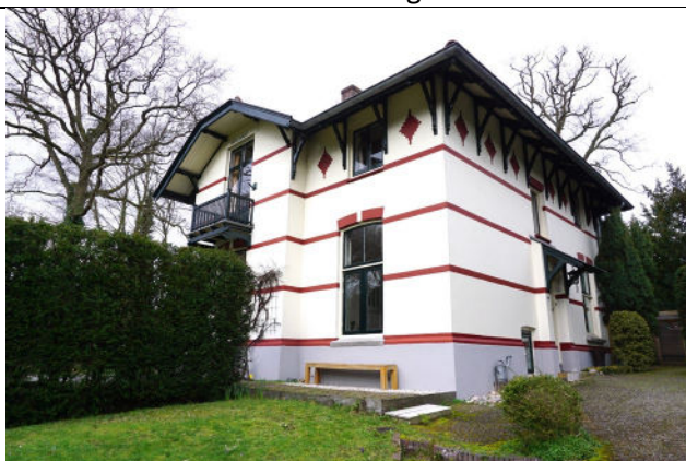
Zuidgevel (links) en oostgevel met entree (rechts)
